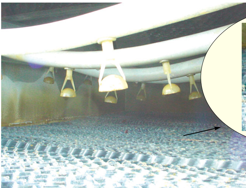
Présence de tartre dans un corps d'échange
