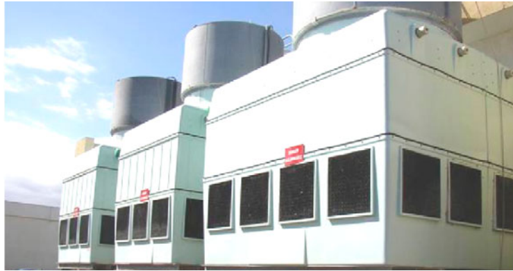
Les trois tours aéroréfrigérantes de l'installation
