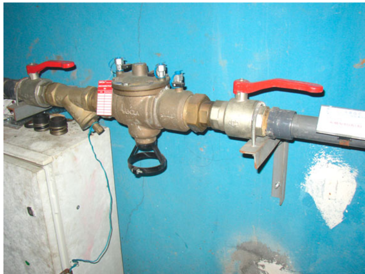
Disconnecteur sur l'arrivée d'eau potable
