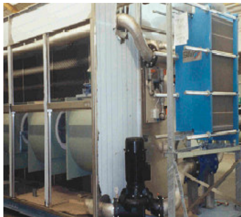
Figure 2B : Echangeur à plaques accolé à une tour de refroidissement
