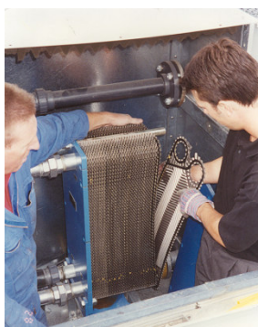
Figure 1J : Assemblage d'un échangeur à plaques
