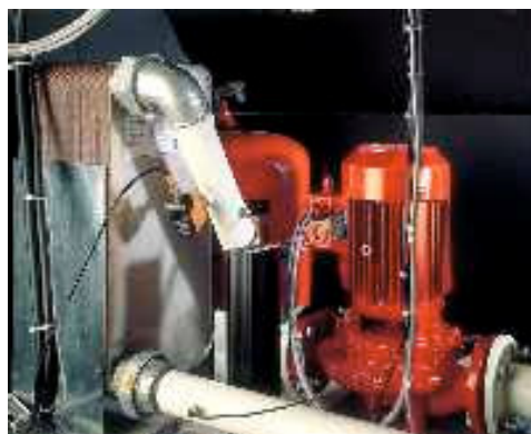
Figure 6C : Illustration d'un évaporateur à plaques muni de son kit hydraulique pour alimentation et retour du fluide à refroidir
